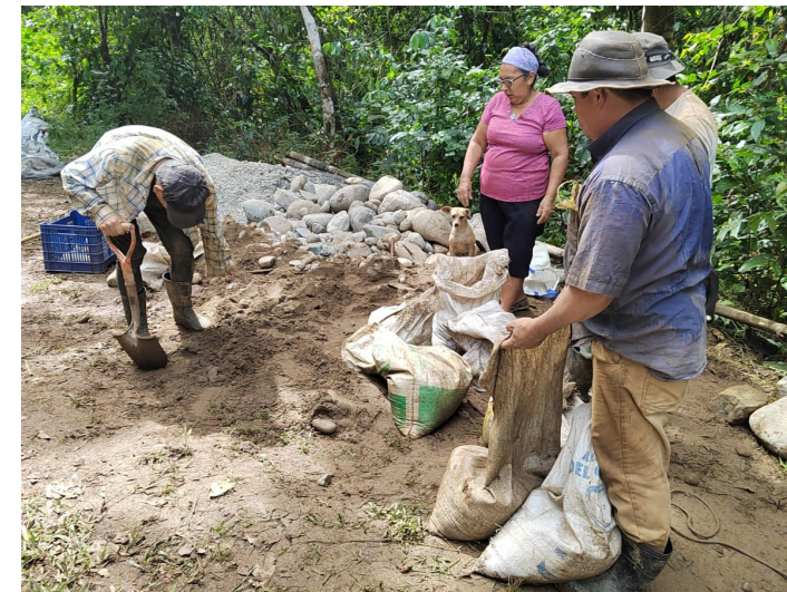
17. Personas de Boruca preparando el traslado de materiales para la construcción del zócalo del santuario de semillas. Nota. De Lourdes Frasser, 2023, Archivo AAF. CC BY-NC 4.0
