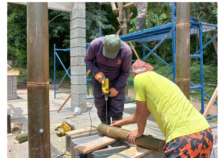
20. Preparando piezas de bambú para instalarlas en el sitio. Nota. Trabajador del PLL y voluntario del taller de construcción con bambú. De Marilía García, 2022, Archivo AAF. CC BY-NC 4.0
