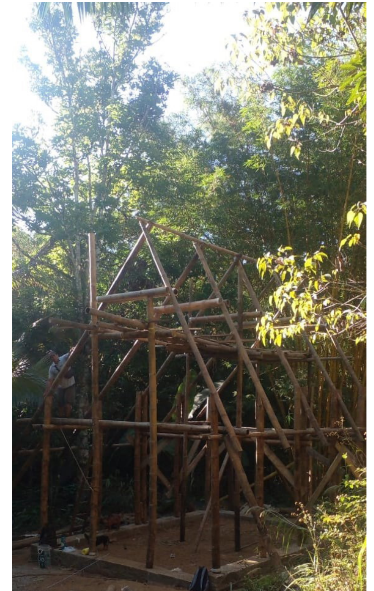
24. Construcción de estructura de bambú del Santuario de semillas. Nota. En la foto Alejandro García, maestro constructor de Boruca. De William García, 2023, Archivo AAF. CC BY-NC 4.0
