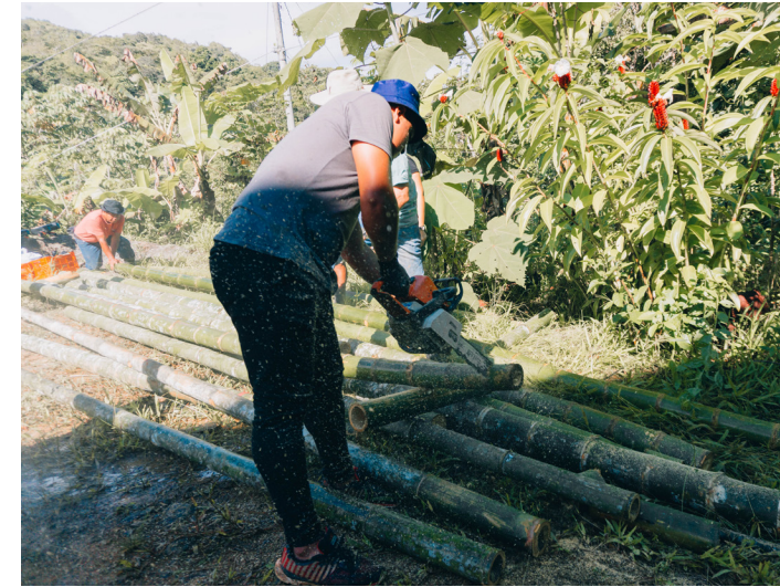
28. Preparando las cañas de bambú para el proceso de curado. Nota. Como parte de la capacitación a la comunidad junto al Proyecto Bambú de la UNA. De Diwö Ambiental, 2021, Archivo Diwö. ©
