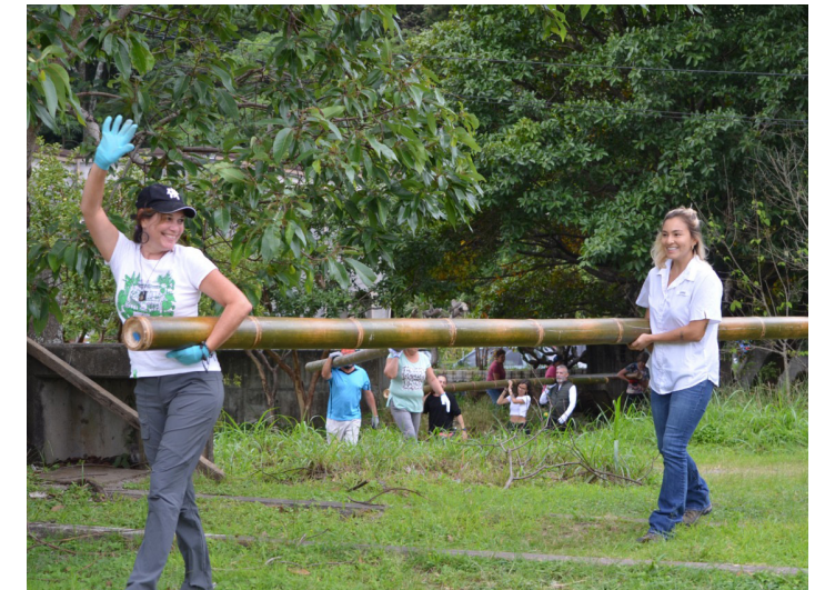
16. Traslado de bambú en las sesiones prácticas del taller de construcción con bambú. Nota. De Sara Ramírez, 2022, Archivo AAF. CC BY-NC 4.0
