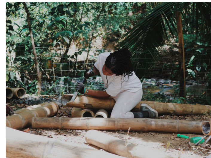
32. Realizando una unión de pico de flauta. Nota. Como parte de la jornada de voluntariado con estudiantes del United World College. De Jimena Araya, 2023, Archivo Diwö. ©
