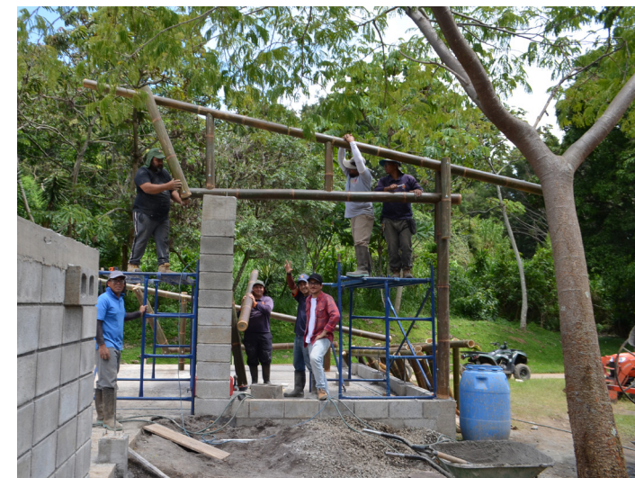
25. Instalación de columnas y cerchas de bambú de la bodega del vivero del PLL. Nota. Trabajadores del PLL. De Sara Ramírez, 2023, Archivo AAF. CC BY-NC 4.0
