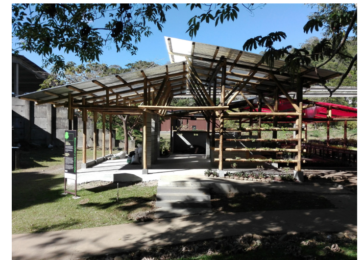
26. Acceso a la Vivero del PLL (Fase I). Nota. En la foto se aprecia el área de bodega (izq.), de atención (frontal), de compostaje (trasero), y de mesas de cultivo (derecha). De Alejandro Alcázar, 2023, Archivo AAF. CC BY-NC 4.0
