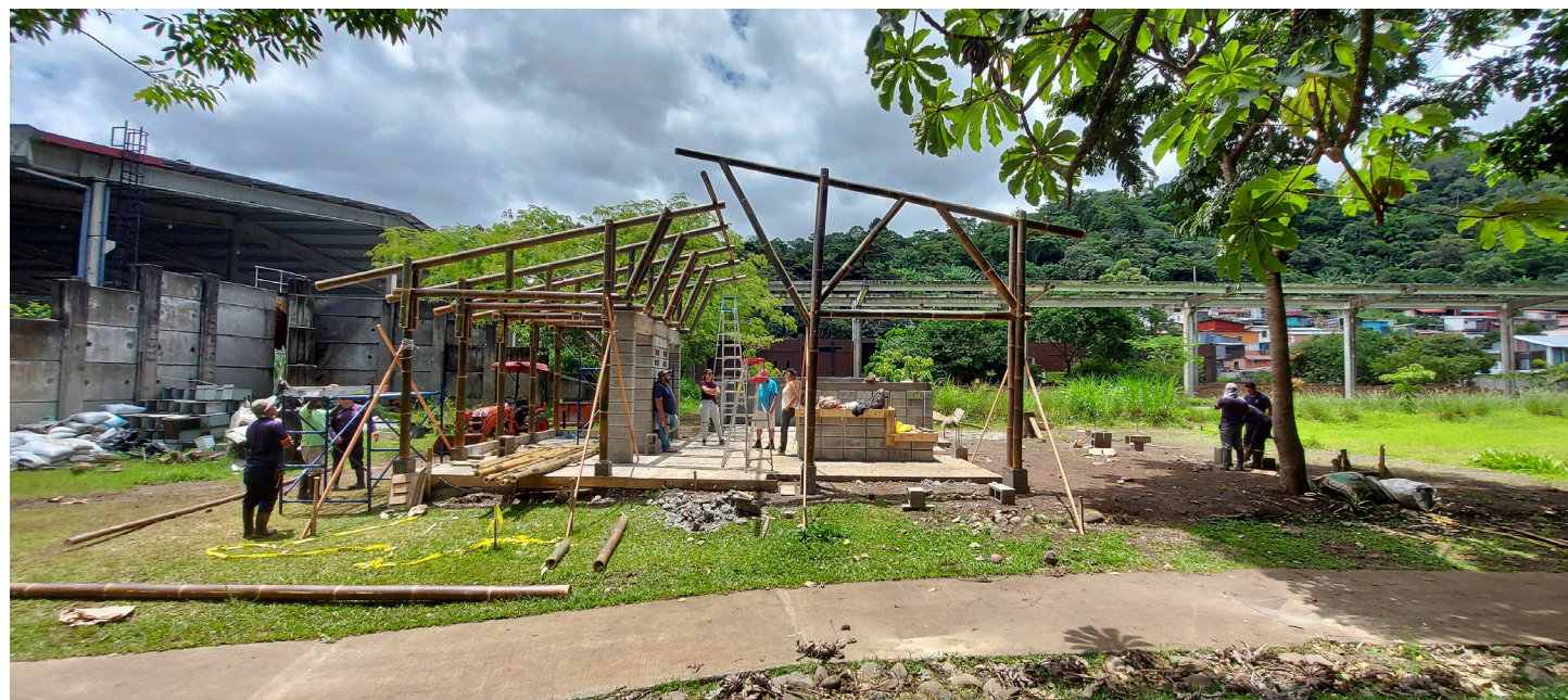
21. Instalación de marco del bloque 2. Nota. Como parte de las sesiones práctica del taller de construcción con bambú. De Héctor Rodríguez, 2022, Archivo AAF. CC BY-NC 4.0
