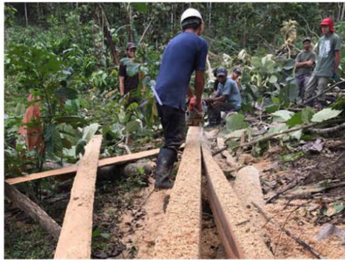
Figura 19 - Maestro Fabián Burbano, miembro de una asociación campesina aliada, aserrando la teca que sería utilizada en las vigas portantes del CCCh. ©Mitsuyoki Kawasaki
