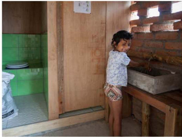
Figura 33 - Los sanitarios compostables plantean una alternativa a la crisis de saneamiento en Chamanga. El sistema de captación de lluvia garantiza acceso a agua corriente por buena parte del año. ©Sebastián Oviedo, Santiago Oviedo
