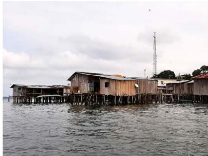
Figura 4- Las casas palafíticas son la forma tradicional de asentamiento en la zona baja de Chamanga, históricamente vinculada a actividades pesqueras. ©Atarraya Taller
