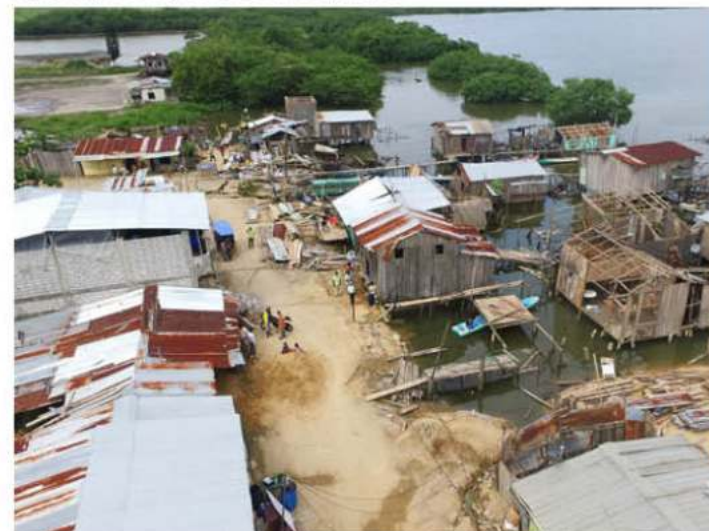
Figura 7- Vista aérea de Chamanga tomada días después del terremoto. ©Fotos y videos Drone Esmeraldas
