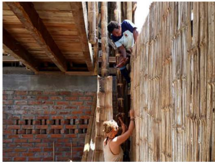
Figura 21 - Mario, de OM, junto a Lena de MUAS armando el soporte en guadúa de la pared de barro. © Atarraya Taller
