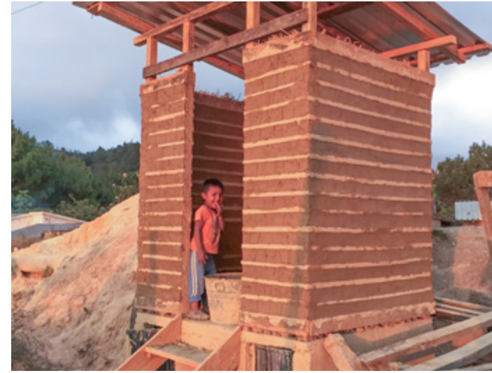
21. Autoproducción de baños secos para disminuir el impacto ambiental. Créditos: Isadora Hastings, Jesús Álvarez.
