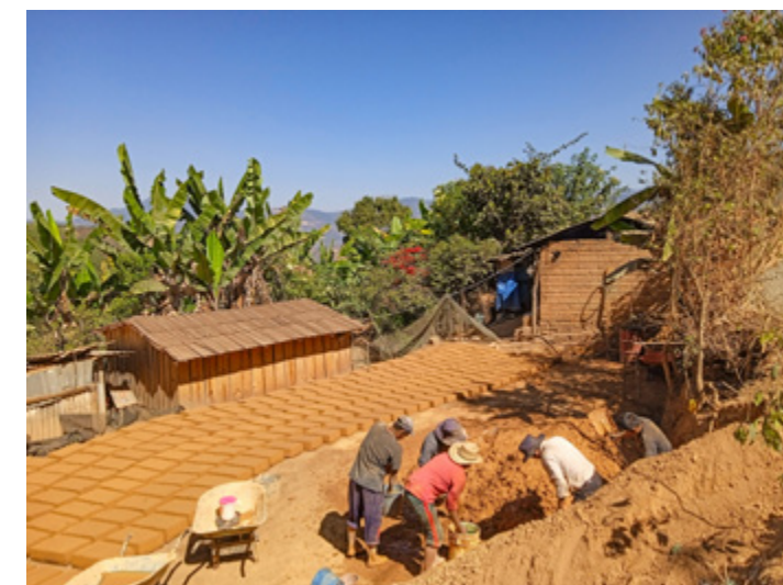
24. Proceso integral y participativo de autoproducción de viviendas con el sistema reforzado de adobe contra sismos y vientos fuertes. Créditos: Isadora Hastings, Jesús Álvarez.
