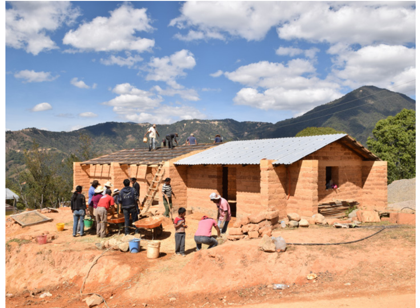
16. Proceso integral y participativo de autoproducción de viviendas con el sistema reforzado de adobe contra sismos y vientos fuertes. Créditos: Isadora Hastings, Jesús Álvarez.
